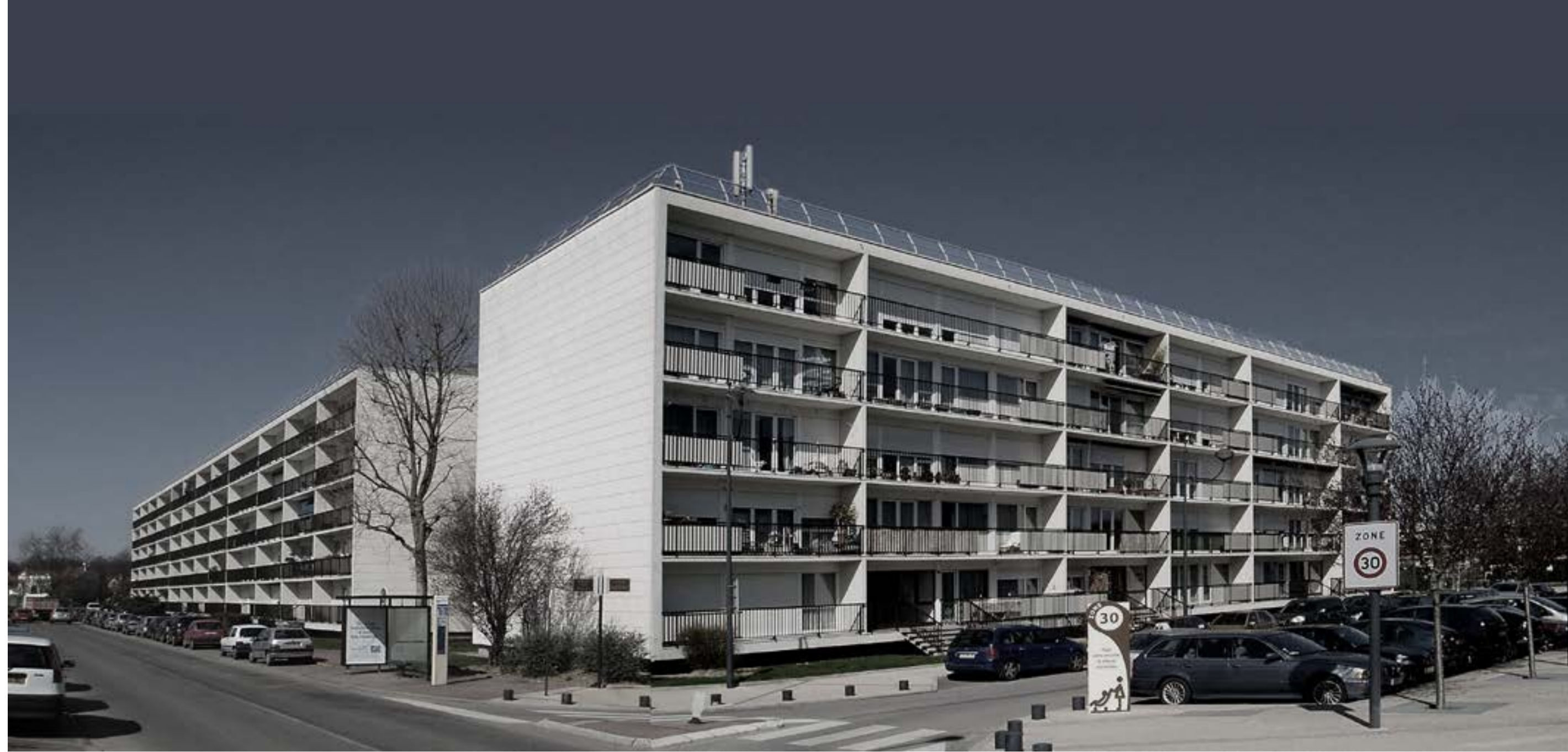
Les bâtiments B et F avant travaux
